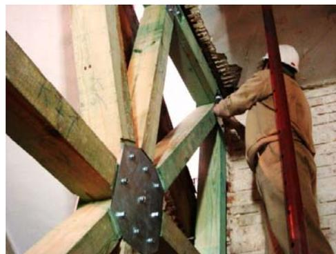
Um exemplo é o de um edifício localizado na Rua do Comércio, também em Lisboa, tipicamente pombalino, em que a estrutura original foi integralmente mantida, substituindo-se as peças deterioradas e melhorando a continuidade dos pavimentos e o contraventamento das paredes principais (Figura 2). Para não interferir com os edifícios contíguos, foram utilizados dispositivos de ancoragem interior (Figura 3).
